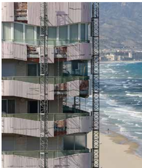
Principe 2: Bescherming tegen indringing van chlorides Torres Blancas, Alicante, Spanje; bescherming met de corrosie-inhibitor MasterProtect 8000 CI
